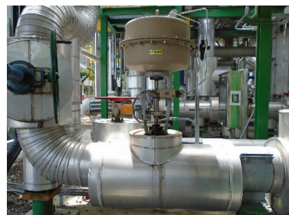
ภาพที่ 2-4 Control Valves
