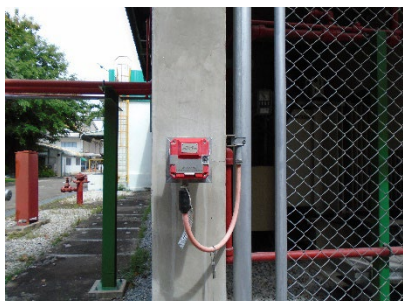
ภาพที่ 2-36 Fire Alarm และแผงควบคุมระบบ Fire Alarm
