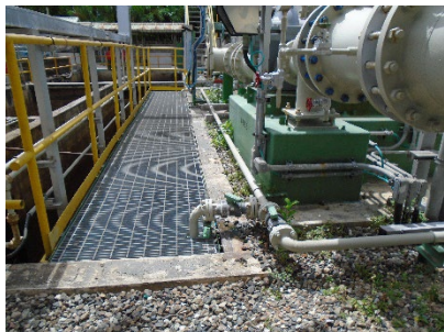
ภาพที่ 2-23 ท่อส่งน้ำทั้งจาก Cooling Tower Blowdown ไป API Separator
