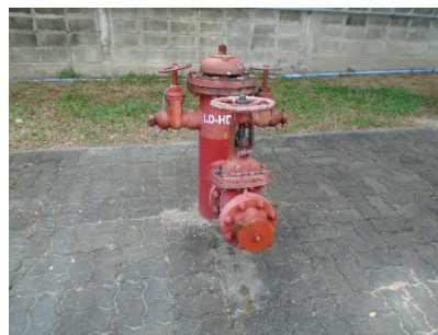
ภาพที่ 2-34 Three-Way Valve (Fixed Monitor)
