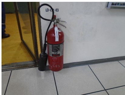
ภาพที่ 2-41 ถังดับเพลิงมือถือชนิด CO 2
