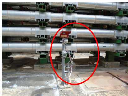
ภาพที่ 2-5 Gas Detector
