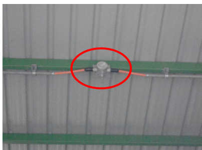
ภาพที่ 2-37 Heat Detector
