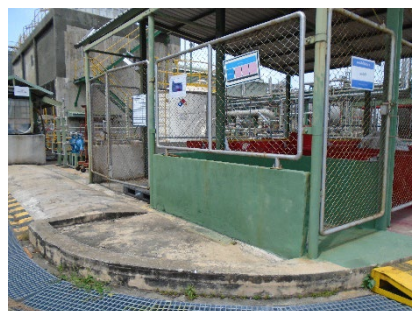
ภาพที่ 2-10 บริเวณที่รวบรวม Low Polymer ที่มีคั่นคอนกรีตล้อมรอบ
