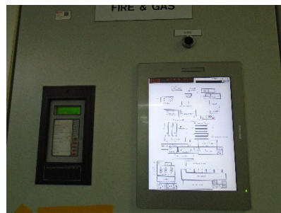
ภาพที่ 2-36 Fire Alarm และแผงควบคุมระบบ Fire Alarm
